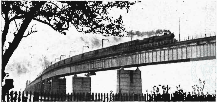
Rys. 7. Most na Storstrom. Pociąg zbliżający się do północnego końca mostu. Uwidoczniony jest ustrój belek stalowych o wysokości 3,6 m.
