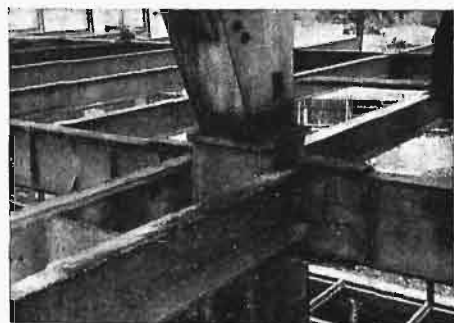
Rys. 10. Styk słupów i połączenia z podciągami.
