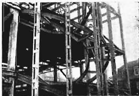
Rys. 15. Okrągła klatka schodowa w czasie montażu.
