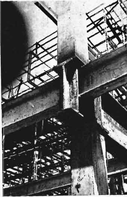
Rys. 14. Połączenie podciągu ze słupami skrajnymi (trakt poprzeczny).
