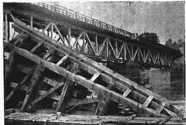
Rys. 12. Izbice i filary mostu.
