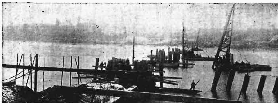
Rys. 2. Stan robót w początku stycznia 1916 r.
