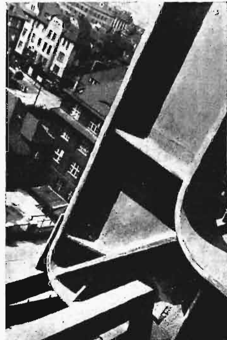
Rys. 1. Dolne naroże konstrukcji ramowej 5-go piętra.
