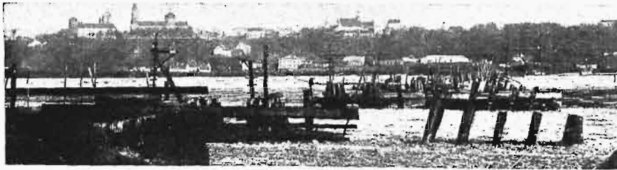
Rys. 3. Stan robót 10 stycznia 1916 r.
