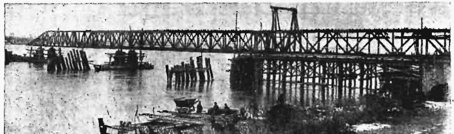
Rys. 6. Stan robót na prawym brzegu Wisły w połowie lutego 1916 r.
