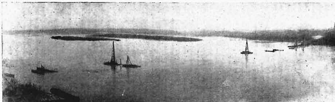
Rys. 1 Stan robót 20 grudnia 1915 r.
