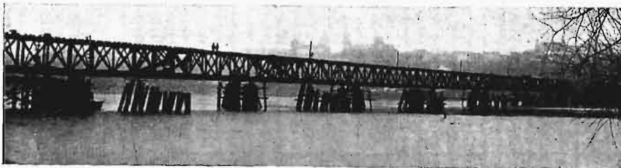
Rys. 10. Stan robót 10 maja 1916 r.
