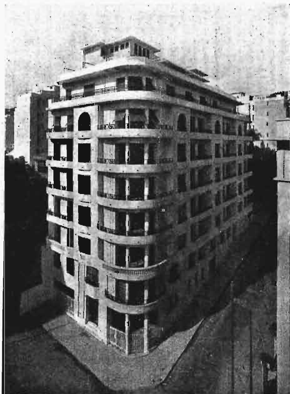
Rys. 9. Jeden z 200 budynków mieszkalnych o szkielecie stalowym wybudowanych w Algierze od roku 1933.
