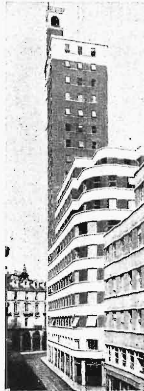
Rys. 13. Wieża „Littoria” w Turynie. Szkielet stalowy całkowicie spawany wagi 795 tonn zmontowano w ciągu 75 dni.
