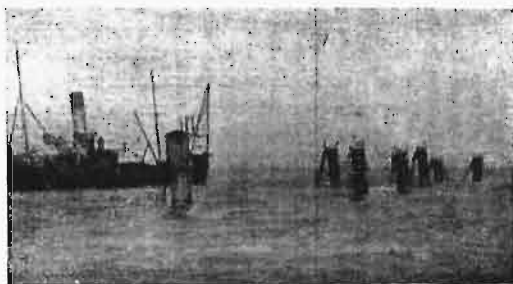
Rys. 1. Szyby powietrzne w terenie. Wierzchołki siedmiu szybów po zainstalowaniu na zatopionym pancerniku.
