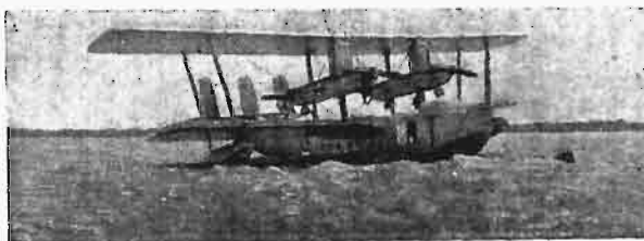
Rys. 2. Short Singapore — 4 silnik Rolls Royce Restler
