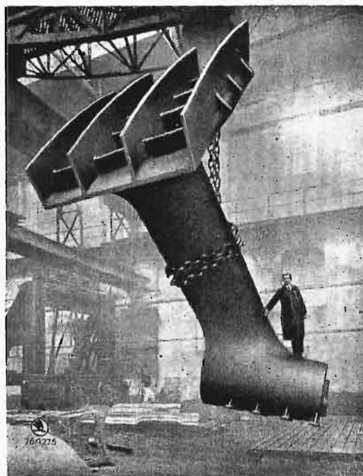
Rys. 3a. Wspornik wału śrubowego. Ciężar 30,8 t, średnica piasty 1,2 m, długość piasty 2,3 m, długość ramienia 4,8 m.
