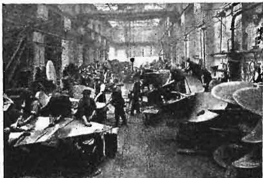
Rys. 5. Obróbka śrub okrętowych.
