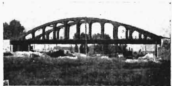
Rys. 1. Most w Hasselt (Belgia) rozpiętości 75 m. Mosty tego typu, przeważnie całkowicie spawane, są ogólnie stosowane w Belgii.
