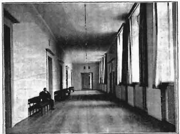
Korytarz I piętra.
