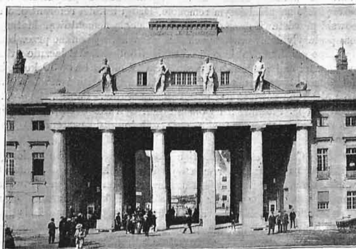
Rys. 4. Wejście główne z zewnątrz i wewnątrz widziane.
