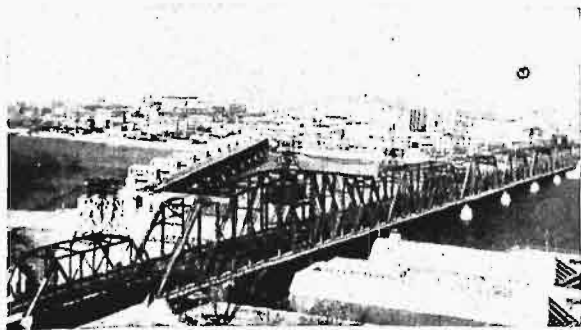
Rys. 1. Widok z brzegu Rock Island w kierunku Davenport. Na pierwszym planie widać śluzę Rock-Island, ponad którą biegną torry kolei żelaznej. Most wyposażony jest w przeszło, obracające się nad wodą.
