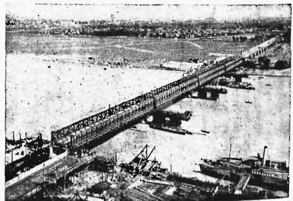
Rys. 3. Widok ogólny mostu podczas przesuwania dn. 12 września 1934 r.
