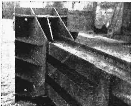
Rys. 8. Spawanie słupa z 3 dwuteowników.
