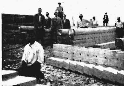
Rys. 7. Przygotowywanie dźwigarów na placu budowy.
