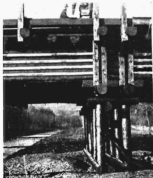
Rys. 6. Jarzmo mostu na rzece Kocierzance.
