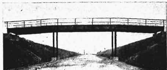
Rys. 4. Widok wiaduktu z boku.
