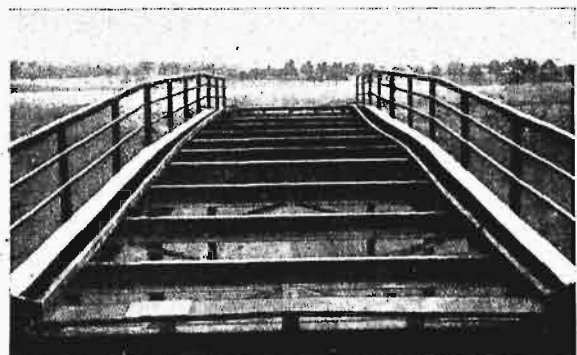
Rys. 3. Wiadukt stalowy spawany nad drogą Wiesbaden-Frankfurt n/M.
