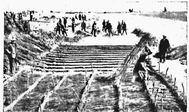
Rys. 23. Materace faszynowe na wale otaczającym zbiornik Wieringermeer,
