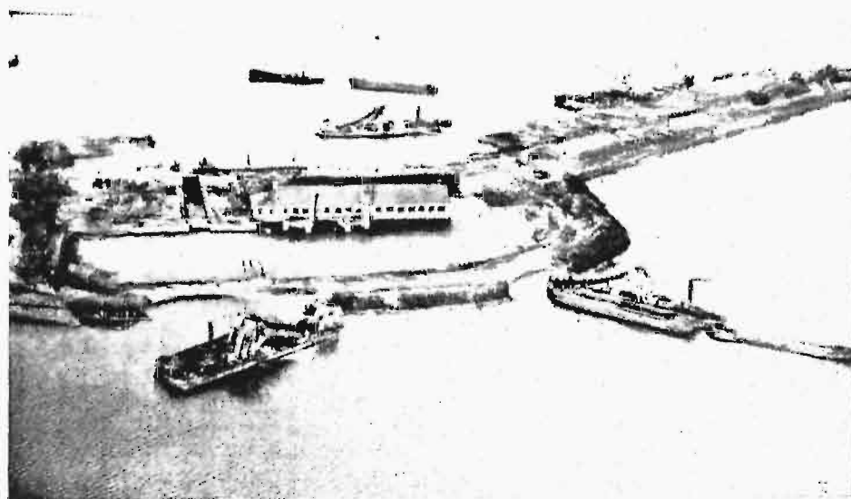
Rys. 34. Zakład pomp pod Den Oever i usuwanie zbytecznych wałów otaczających miejsce budowy.
