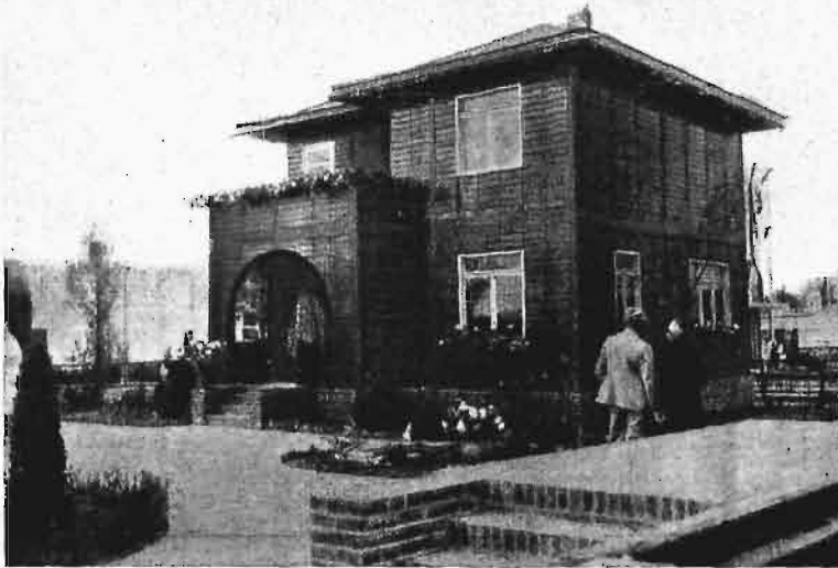
Rys. 12. Domek miedziany, montowany w ciągu 24 godzin.
