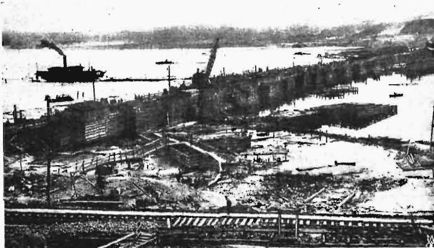
Rys. 10. Elektrownia „Dnieprostroi”. Budowa środkowej (ostatniej) części zapory. Poprzednio wykonano już fundamenty i filary zapory kolejno przy brzegu prawym i lewym, oddzielając miejsce budowy przegrodami szczelnymi z „klatek” drewnianych. Obecnie zagrodzono w ten sposób środkową część rzeki, przepływ zaś wody odbywa się przy lewym brzegu.
