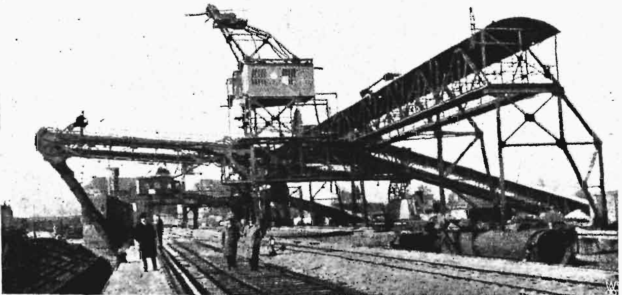
Rys. 19. Wywrotnica o niskim poziomie wyładunku z przenośnikiem taśmowym, zainstalowana w Gdańsku.
