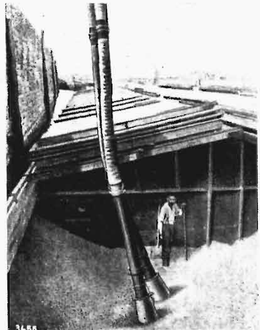
Rys. 23. Ssawki przenośnika pneumatycznego podczas pracy.
