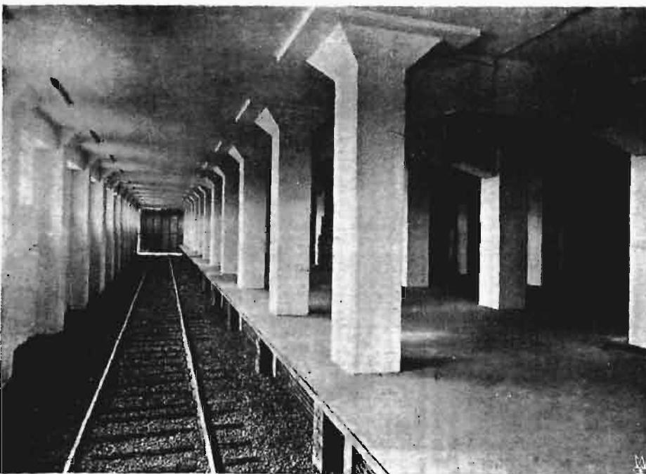
Tor kolejowy w budynku chłodni.
