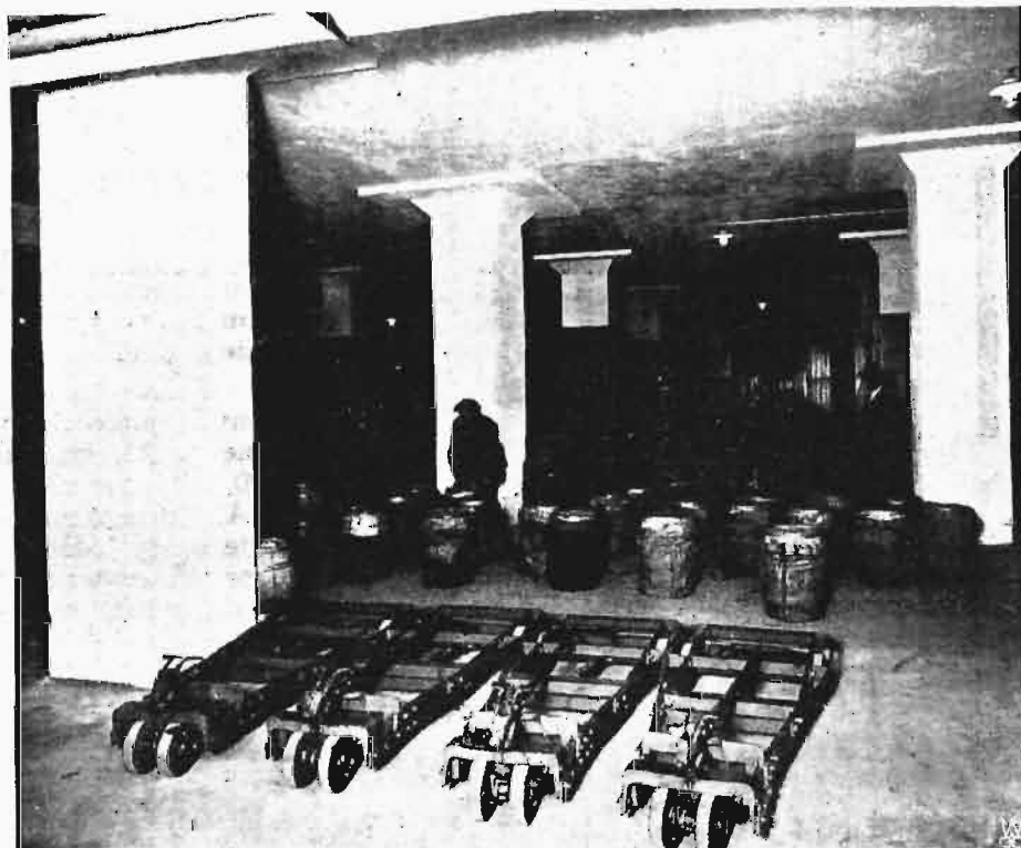
Komora chłodnicza na masło. Na pierwszym planie widać wózki, służące do transportu wewnątrz chłodni.
