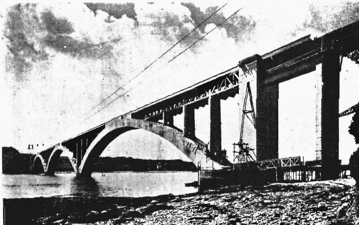
Rys. 7. Widok mostu na zatoce Elorn koło Brest'u o największych na świecie łukach żelbetonowych (rozpiętość każdego łuku 186,5 m).
