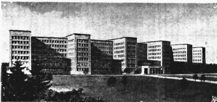
Rys. 2. Ogólny widok budynku.
