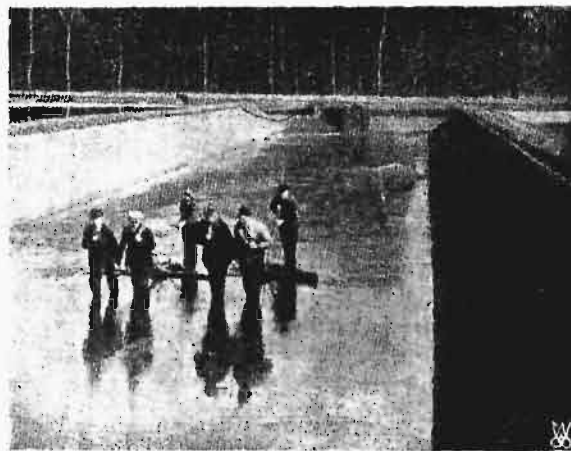
Rys. 1. Ręczne usuwanie namułu z dna osadnika.
