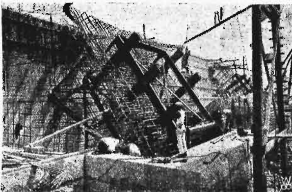
Rys. 3. Zakotwienie w filarze ramy pod blok łożyskowy łuku.
