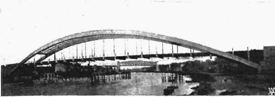
Rys. 1. Ogólny widok mostu.
