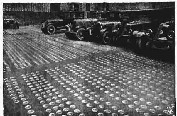
Rys. 6. Strop szklano-żelazo-betonowy.
