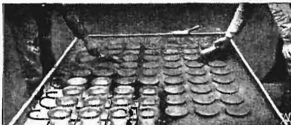
Rys. 4. Wykonywanie płyty szklano-żelazo betonowej.
