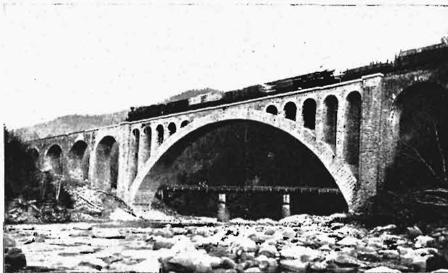
Most kolejowy na Prucie pod Jaremczem po odbudowaniu. W tyle most drogowy.
