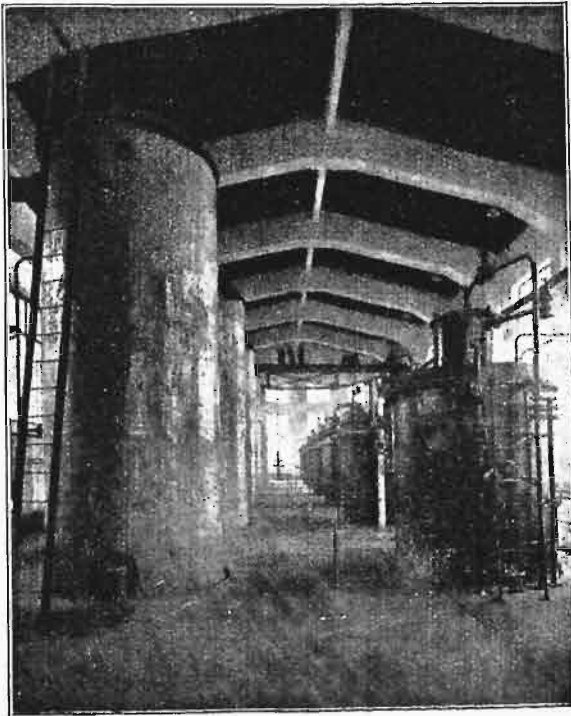
Rys. 7. Hala aparatury konwersji gazu wodnego.
