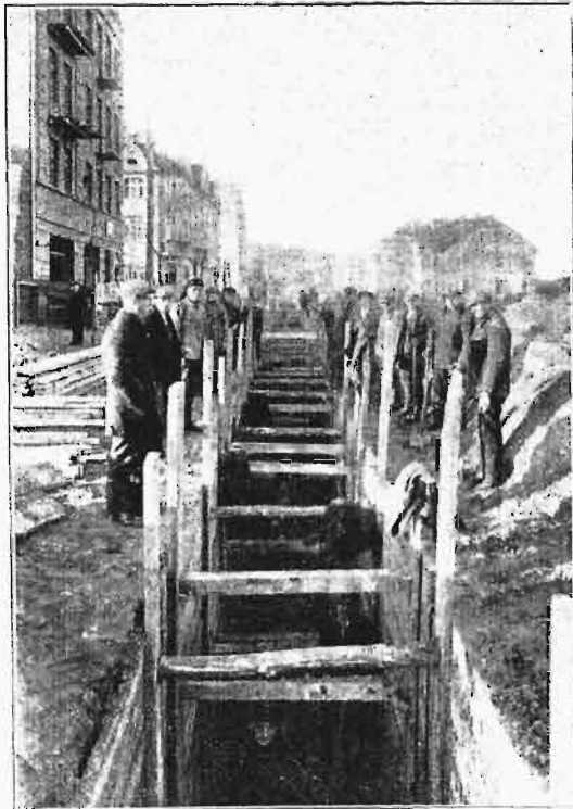
Rys. 23. Budowa kanału deszczowego Nr. 2 w ul. 10 Lutego.
