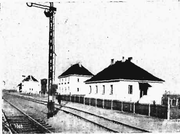
Rys. 8. Typowa stacja mała na linii Bydgoszcz—Gdynia.
