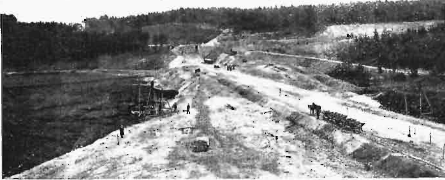
Rys. 13. Roboty ziemne na bagnie o głęb. 16 m pod st. Kack Wielki.
