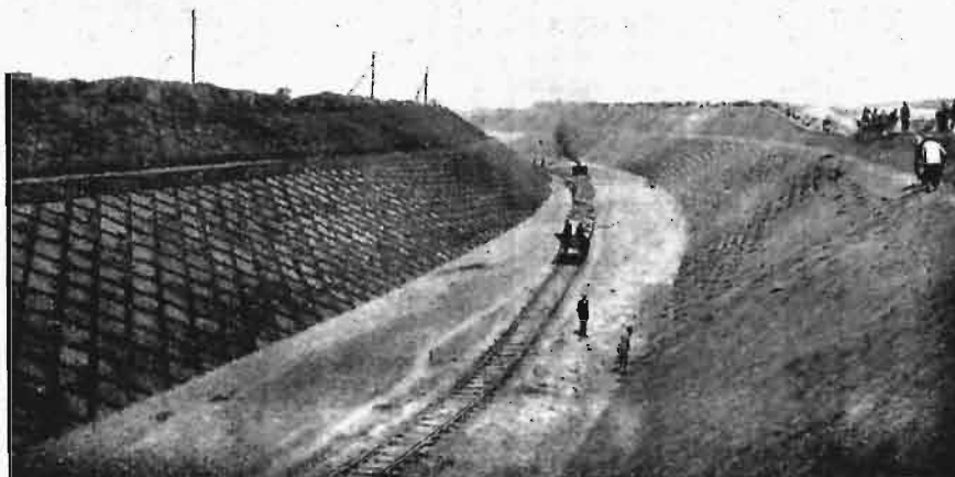
Rys. 12. Wielki wykop za st. Kack Wielki o głęb. max. 19,35 m.
