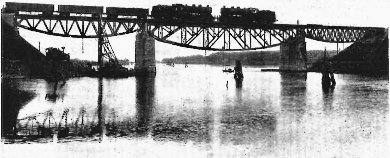
Rys. 7. Ogólny widok mostu na rz. Brdzie .
