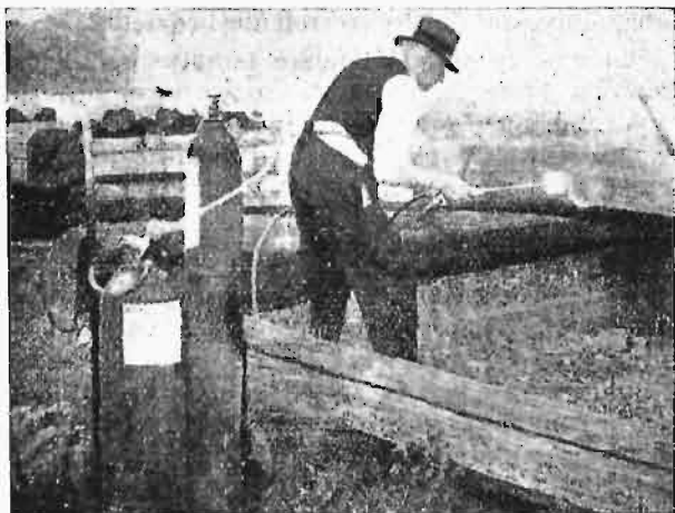
Rys. 11. Opalanie drzewa w celu konserwacji zapomocą palnika acetylenowo-tlenowego.
