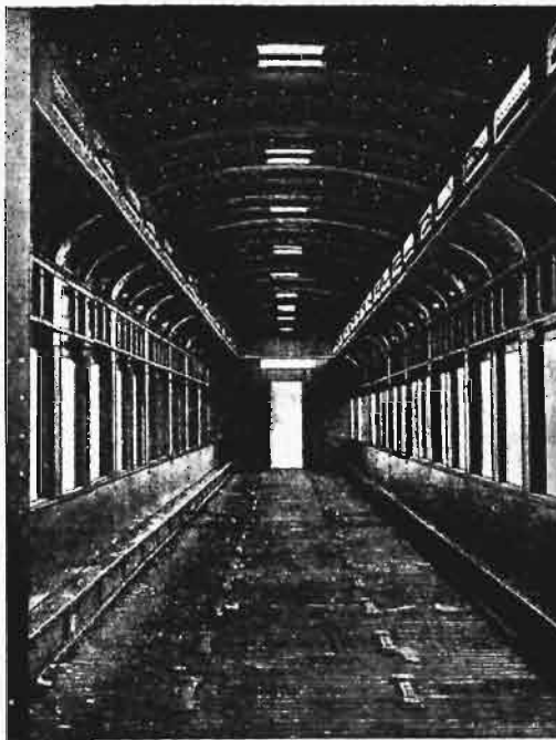
Rys. 2. Szkielet stalowy pudła wagonu.
