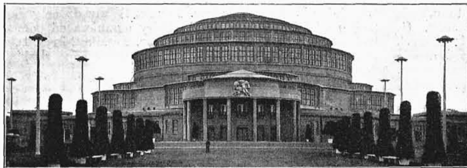
Rys. 5. Widok zewnętrzny hali.
