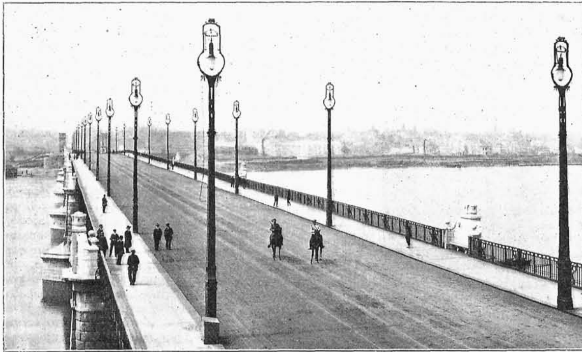
Rys. 2. Widok mostu z góry.
