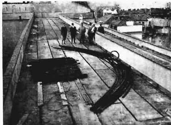
Rys. 21. Przygotowany materiał rurowy do budowy kopuły.
