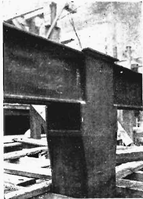
Rys. 25. Rusztowanie do budowy stropu.
