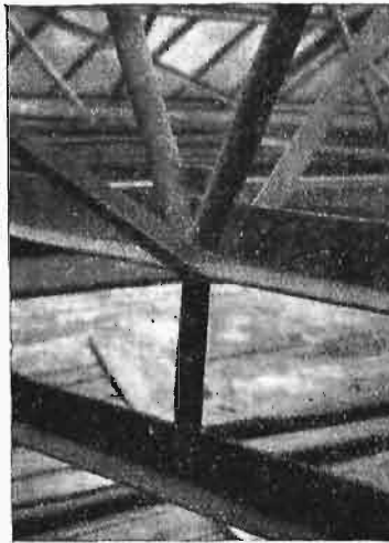
Rys. 15. Podwieszenie sufitu.
