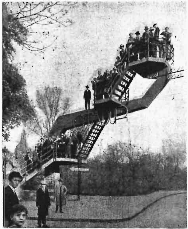
Rys. 2. Widok budowli obciążonej ludźmi.
