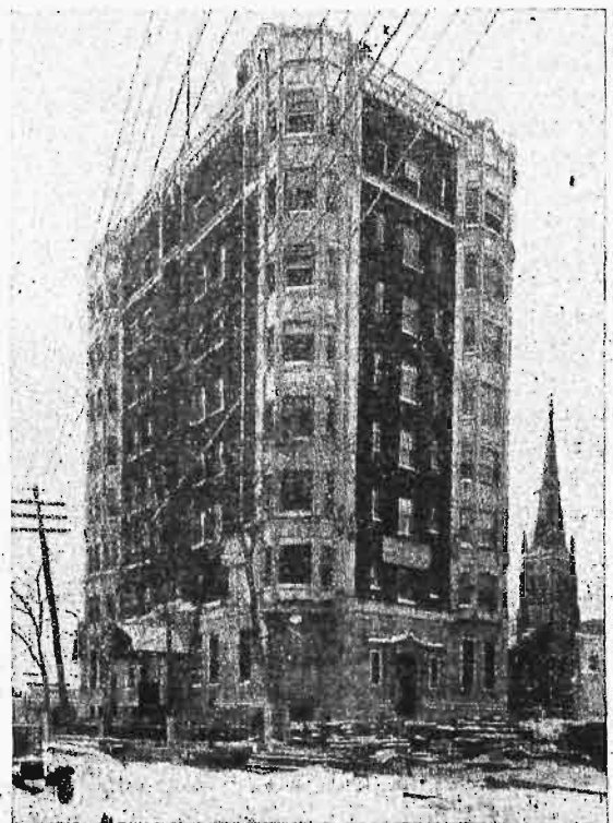
Rys. 1. Widok 8-piętrowego budynku, który został przesunięty o 150 m. (do art. na str. 111).
