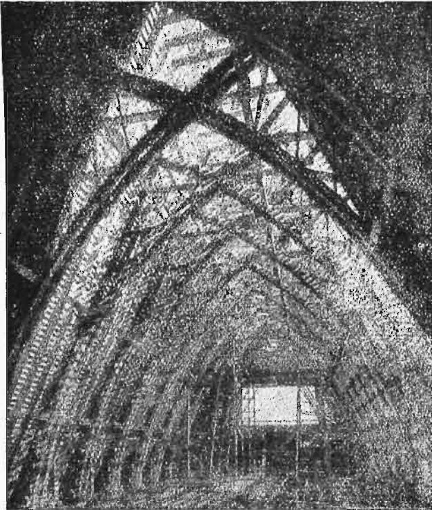
Rys. 2. Widok żelbetowych wiązarów dachu.
