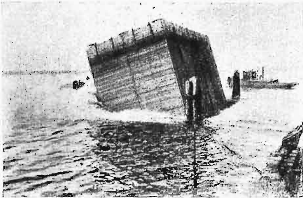
Rys. 1. Przygotowanie do budowy filarów mostu. Zatopienie kesonu.
