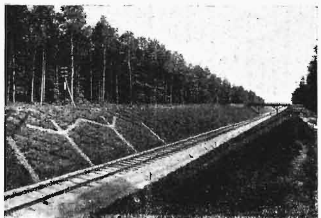
Rys. 2. Odwodnienie wykopu na km. 23.
