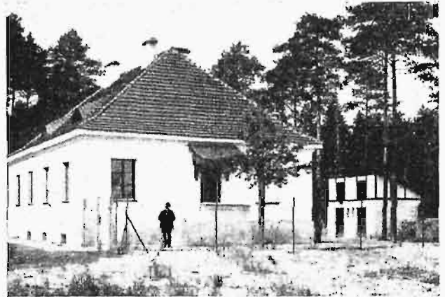
Rys. 6. Dom dozorczy drogowego na st. Herby Nowe.
