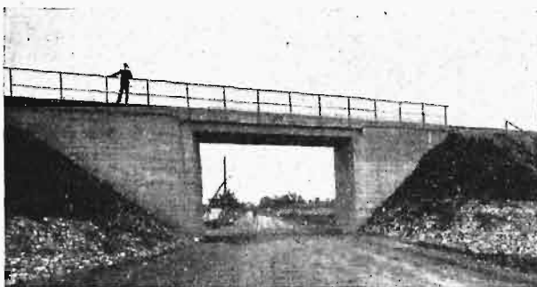
Rys. 5. Wiadukt żelbetowy na km. 82.
