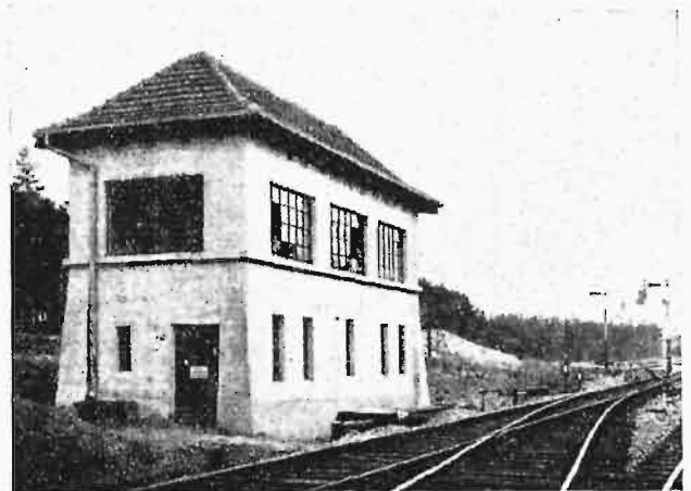
Rys. 7. Budynek stawidłowy na st. Herby Nowe.
