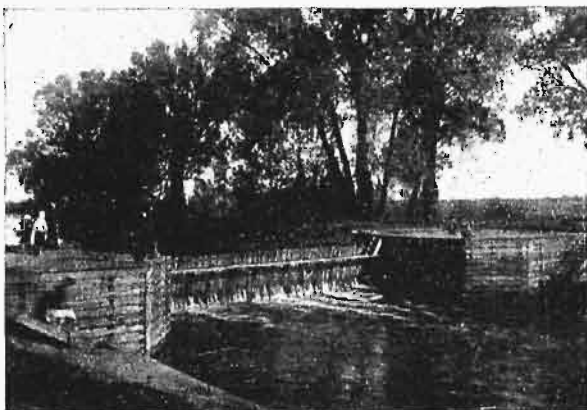
Rys. 8. Jaz na Muchawcu (odbudowany).
