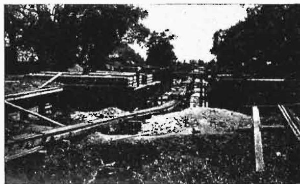
Rys. 9. Odbudowa jednej ze śluz na kanale Ogińskiego.
