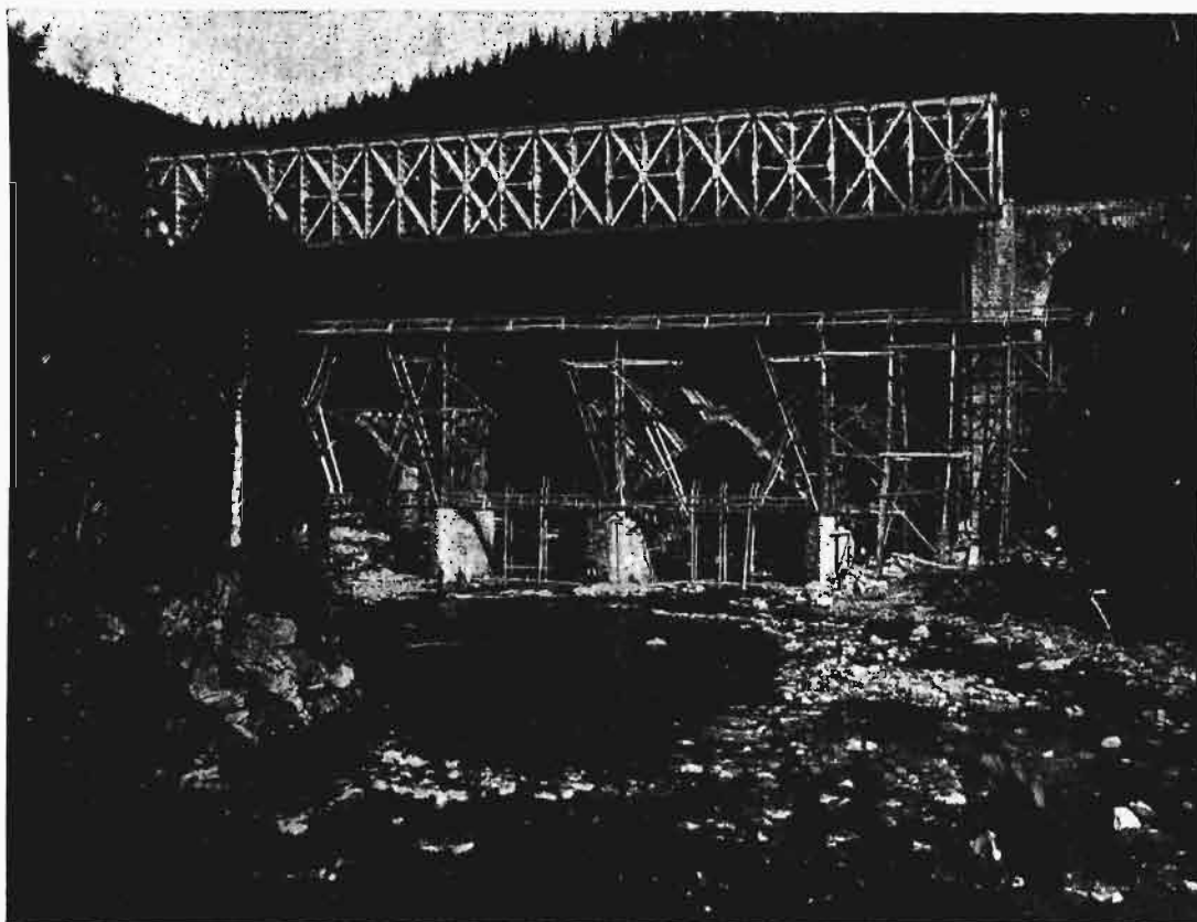
Rys. 12 Ogólny widok robót z góry rz. Prutu.
