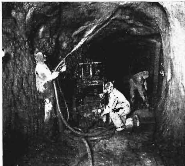
Rys. 3. Obrzucanie cementem chodników podziemnych.
