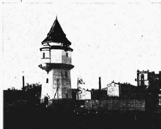
Rys. 12. Wieża ciśnienia na st. Żyrardów, dyr. Warszawskiej.
