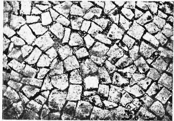
Rys. 2. Wygląd nawierzchni raz przewalcowanej, Grysik jest wciśnięty z dołu do szczelin pomiędzy kamieniami.
