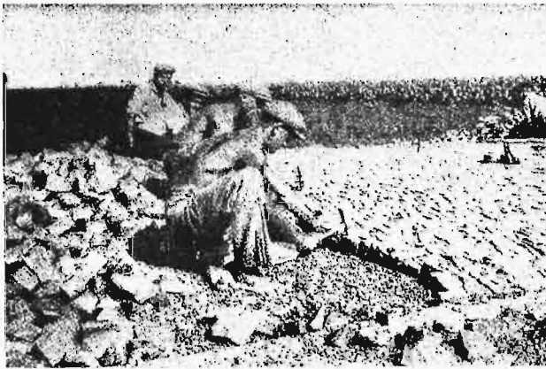
Rys. 1. Ręczne układanie kamienia na podłożu z grysiku.
