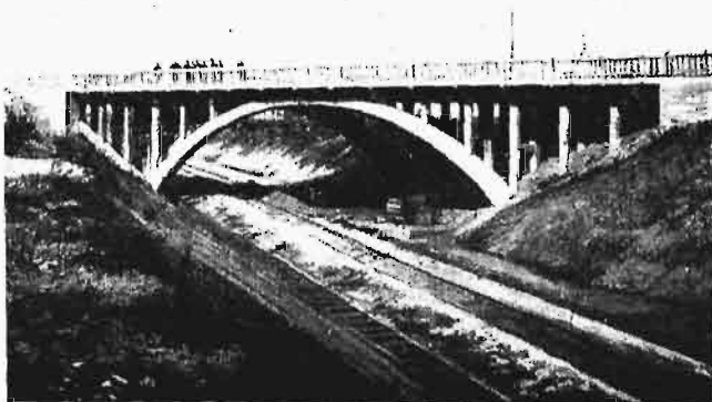
Rys. 8. Wiadukt na szosie Łęczyca — Krośniewice.
