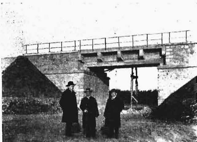
Rys. 7. Wiadukt pod szosą Marysińską.
