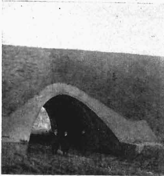
Rys. 4. Przepust sklepiony o otworze 6,4 m (rz. Łódka pod Łodzią).
