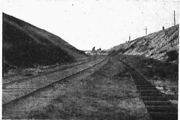
Rys. 5. Wykop pod Ozorkowem.
