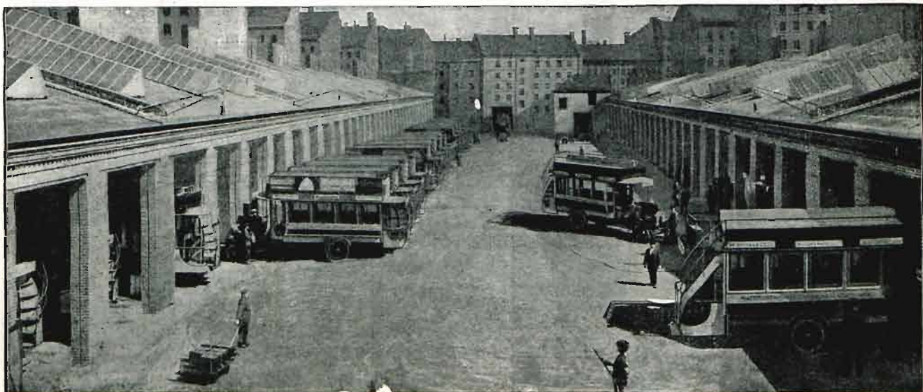
Garaz autobusowy z zastosowaniem opisanego wyżej systemu.
