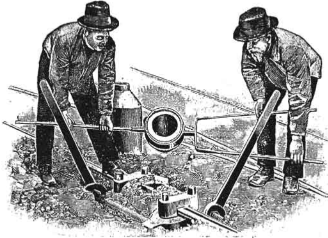
Spawanie szyn w linii. (Zalanie termitem).
