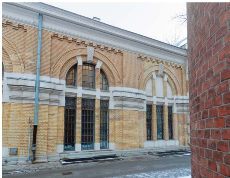
Gmach Starej Kotłowni po kapitalnym remoncie, 2015 (fot. A.A. Wagner)
