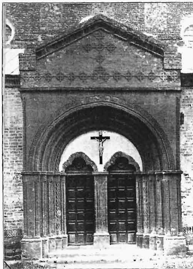
Kościół św. Jakóba w Sandomierzu. Portal w nawie północnej.
