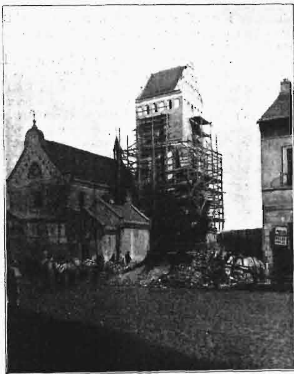
Rys. 4. Kościół N. M. P. na Nowem Mieście w Warszawie. Kierownik restauracji arch. T. Wiśniowski.
