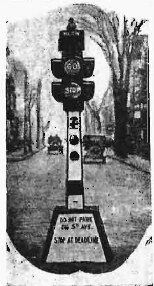
Rys. 67. Sygnał elektryczny na stałej podstawie wzniesiony po środku ulicy.
