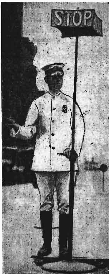
Rys. 64. Semafor używany w m. Buffalo, N. Y., bardzo często spotykany i w innych miastach amerykańskich.
