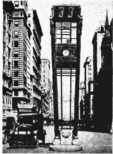
Rys. 66. Jedna z wież na 5-iej Ave w Nowym Jorku, z której regulowany jest cały ruch na tej ulicy, przez zapalanie światel kolorowych na innych wieżach.
