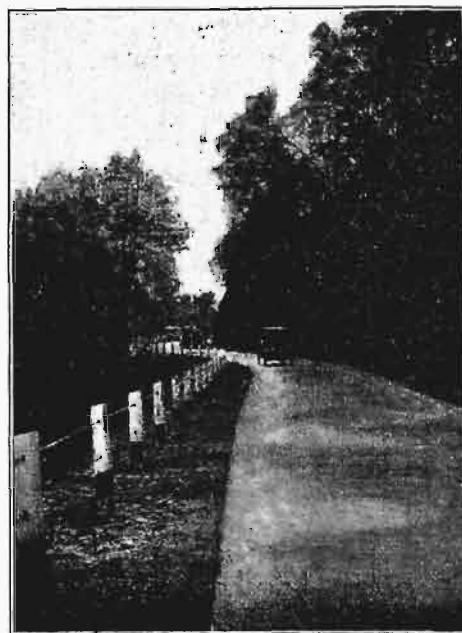
Rys. 51. Poręcz ochronna ze słupów drewnianych i dwóch lin stalowych.
